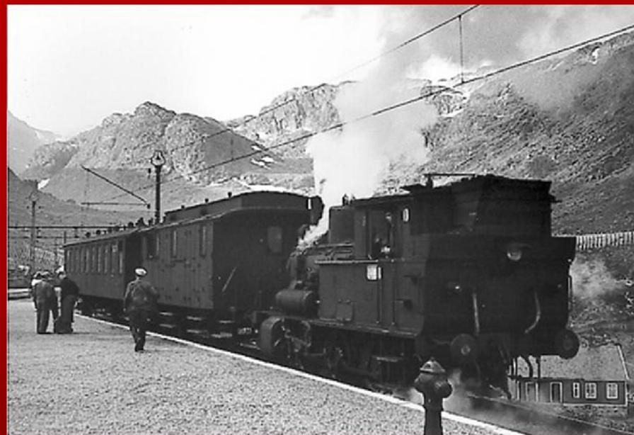
Der Bau der Flåmbahn wurde bereits im Jahr 1923 beschlossen. Aufgrund der Schneebedingungen und der Bedingungen längere Züge in den steilen Streckenabschnitten bis 55 Promille und Kurvenradien bis 125 m zu fahren, kam der Beschaffung besonderer Lokomotiven Bedeutung zu. Militärisch hatte die Flåmbahn keinerlei Bedeutung und war während der Kriegsjahre nur für den Binnenverkehr von Interesse.
