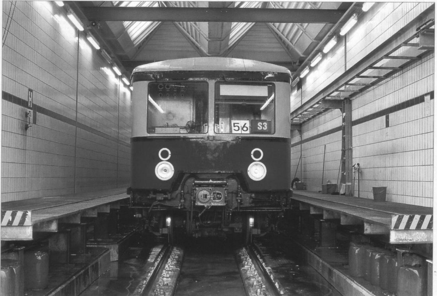
In der Waschstraße des S-Bw Berlin-Wannsee stand am 21. Oktober 1997 der Triebzug 477 041. Diese Anlage ließ die Berliner Verkehrs-Gesellschaft 1984 während der grundlegenden Modernisierung der Betriebswerkstatt errichten
