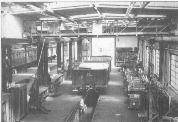
Blick von der ersten Etage auf die Reparaturhalle in Wannsee 1976. Die Halle bot einem Viertelzug Platz für größere Reparaturen. Rechts ist das Materiallager für die Großteile
