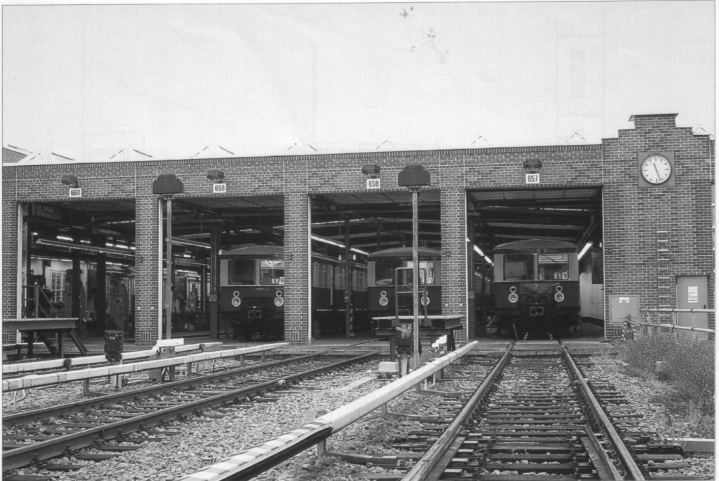
Das Mauerwerk des Rechteck-Lokschuppens im Bahnbetriebswerk Berlin-Wannsee wurde mit roten Tonplatten verblendet. Auf den vier Gleisen fanden bei der Betriebseröffnung im Frühjahr 1933 insgesamt 16 Viertelzüge Platz
